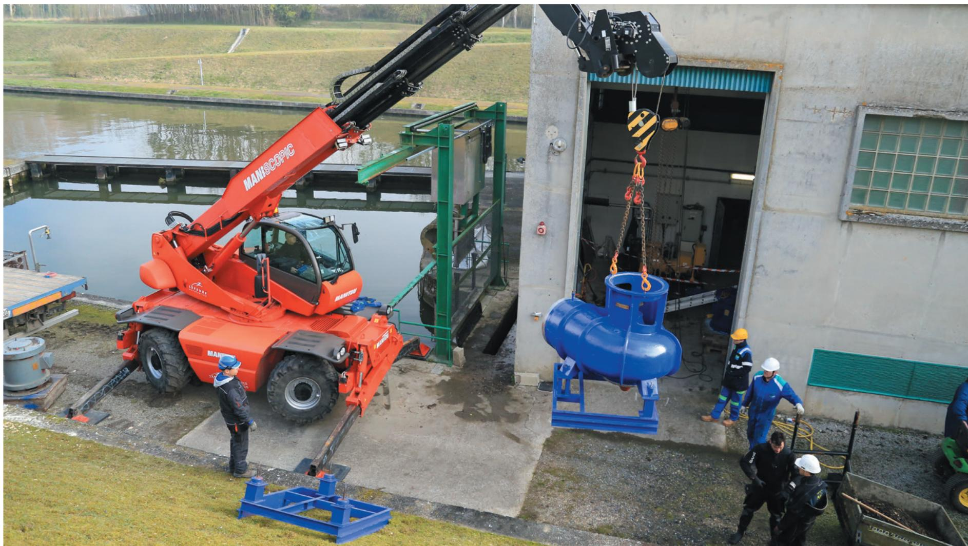
Canal du Nord Ecluse N°15 de Languevoisin, remplacement d'une pompe de relevage.
